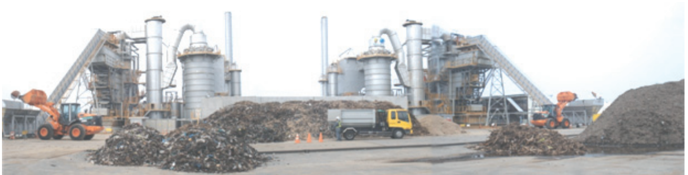
▲中間処理プラントの仮設焼却炉の状況
