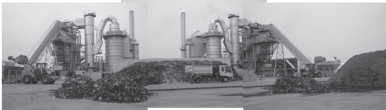
▲中間処理プラントの仮設焼却炉の状況
