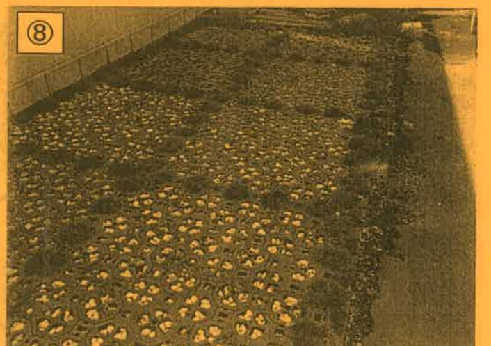
⑧キューブブロックは、簡単に敷く事ができ、駐車場にも活用できる、とのことでした。
