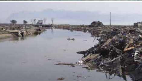
開運橋 上)平成20年7月 下)平成23年3月 震災で市登録文化財の開運橋は 完全に崩落した
