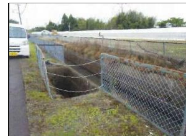
不備のある安全施設の修繕
