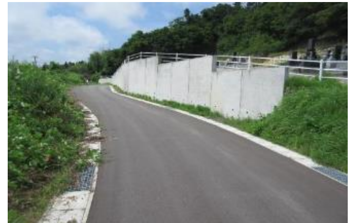
愛島53号線(上施工前・下施工後)
