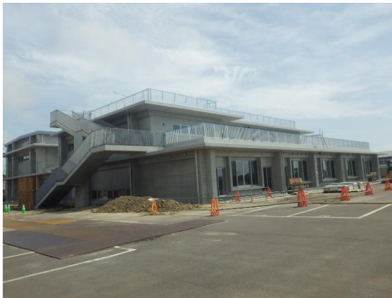
現在建設中の施設
