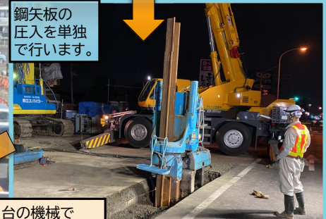
2台の機械で削孔と圧入を各々で行います。
