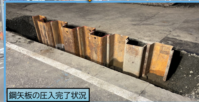
1台の機械で削孔と圧入を同時に行います。
