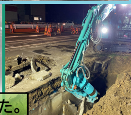
2台の機械で削孔と圧入を各々で行います。
