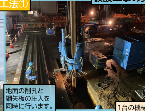
1台の機械で削孔と圧入を同時に行います。
