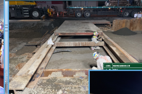
路面覆工の解体を行いました。
