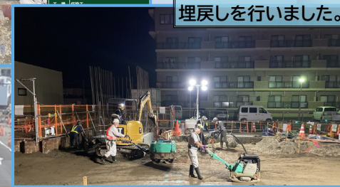
充填材の穴埋め効果によって周辺路面の沈下を防止します。
