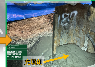
充填材の穴埋め効果によって周辺路面の沈下を防止します。
