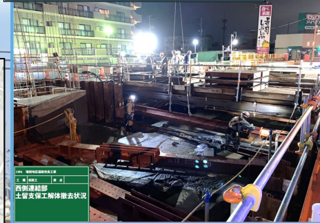
土留支保工を解体を行いました。
