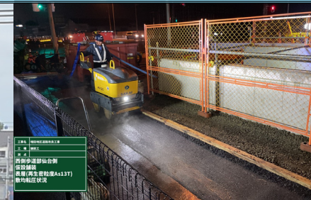
西側鋼矢板引抜き箇所の舗装復旧を行いました。
