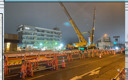
西側鋼矢板の引抜き作業を行いました。
