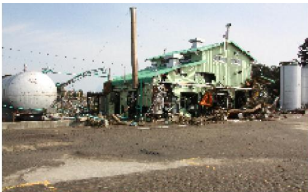
【被災した再生処理工場】
