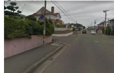
②歩道側溝に蓋がなく危険
