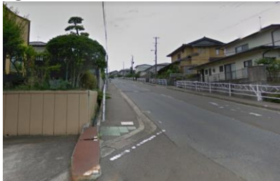
①歩道側溝に蓋がなく危険
