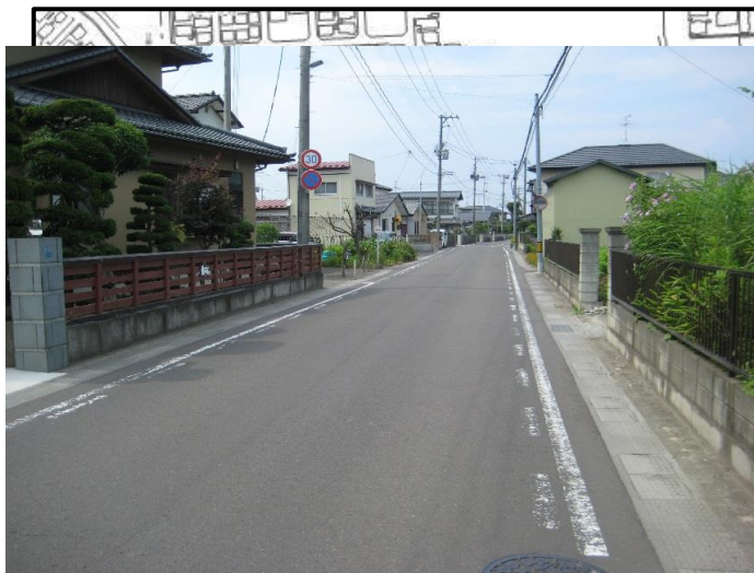
県道のカラー舗装前状況(飯野坂六丁目付)
