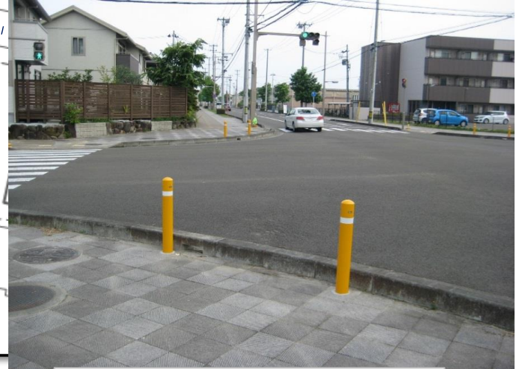
車止めポール設置後の状況
