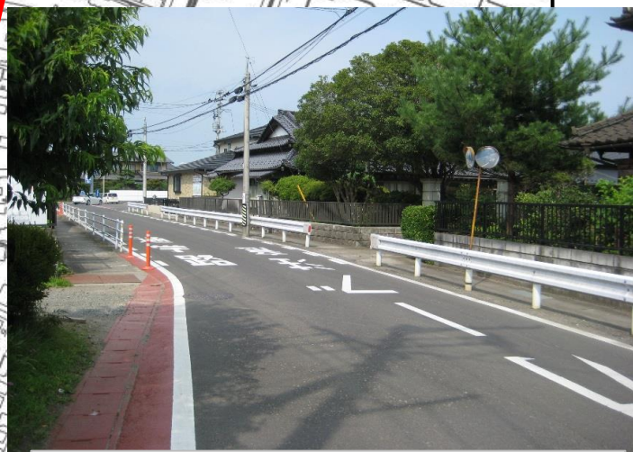
県道のカラー舗装状況(植松三丁目付)
