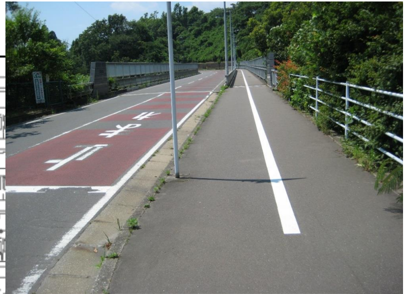
歩道の分離線表示状況
