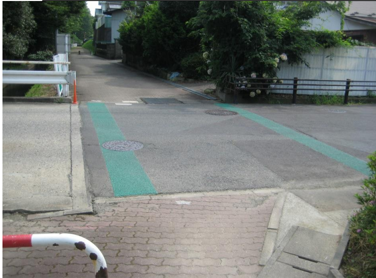
遊歩道付近のカラー舗装状況(飯野坂六丁目北)
