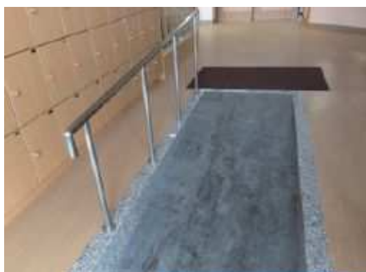
写真 6. 昇降口のスロープ
