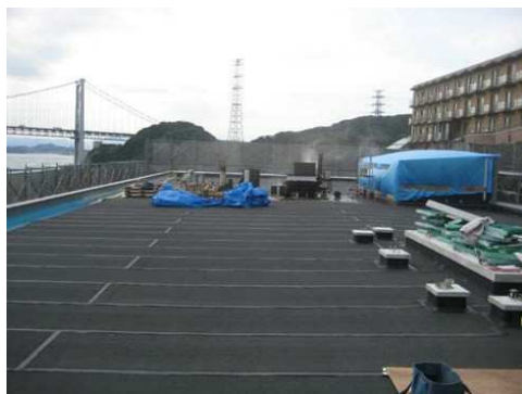
写真1 アスファルト防水
