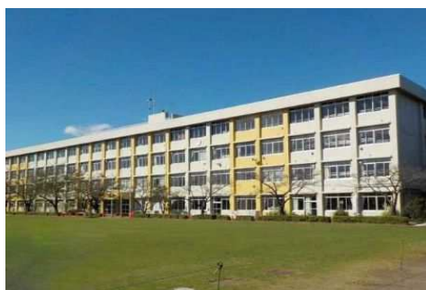
写真3 改修後の校舎外観
